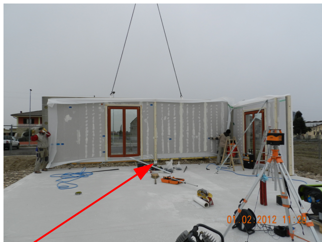
01/02/2012 ore 11, 29' parete perimetrale
