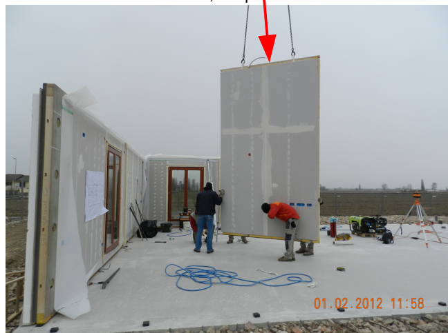
01/02/2012 ore 11, 58' parete interna
