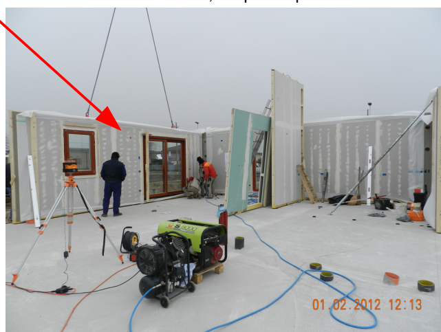
01/02/2012 ore 12, 13' parete perimetrale
